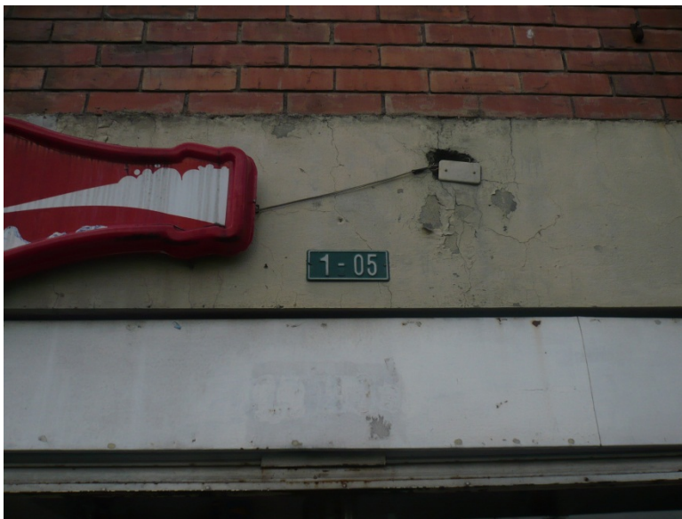
Fotografía No. 2: Nomenclatura del Establecimiento CAFETERÍA ULTRAPAN ubicado en la Carrera 78 No. 1-05.
